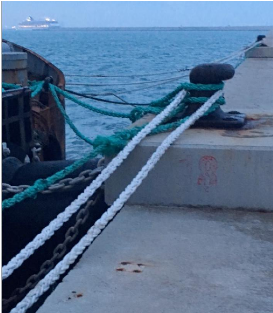
Foto 4 – Nuovi ormeggi a prua sulle bitte della banchina
